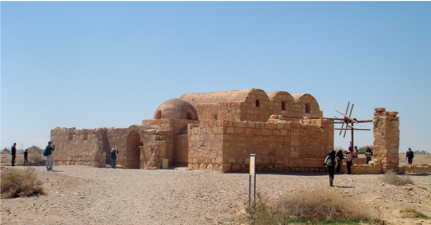
13. Vista est / East view.
