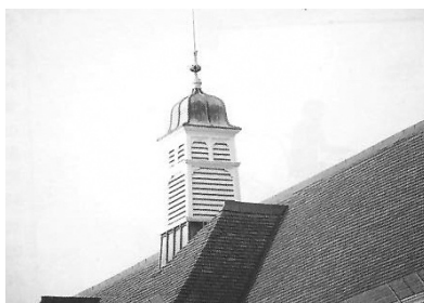
Figura 5. Elementi per la ventilazione naturale adoperati nell'architettura vittoriana.
