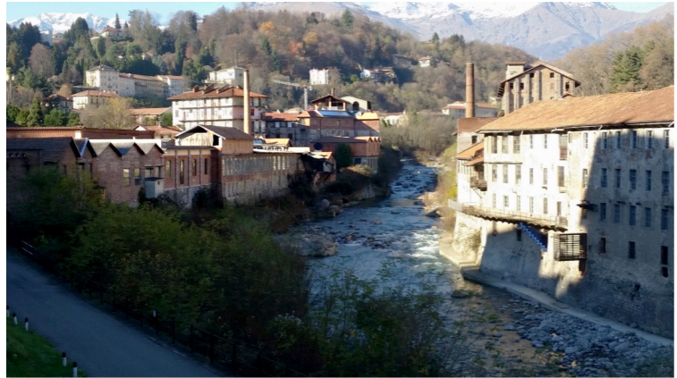
Figura 19. Vista de dos de los edificios más significativos de Biella frente al arroyo Cervo. A la izquierda el antiguo Lanificio Trombetta, ahora sede de Cittadellarte - Fondazione Pistoletto, y a la derecha parte del antiguo Lanificio Maurizio Sella. Autora: Cristina Natoli.
