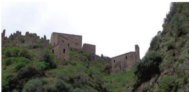
Figura 2. Precacore, edifici restaurati (foto D. Bramato)
