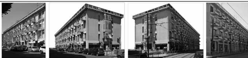
10. Particolare del prospetto dell'isolato 4.
