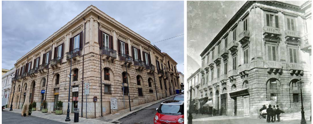
Fig. 2. Palazzo Melissari-Nesci, Reggio Calabria. A destra: foto prima del terremoto del 1908. Archivio Nesci, Reggio Calabria [Manfredi 2008, p. 252]. A sinistra: Stato attuale del palazzo, il terzo piano fuori terra fu demolito dopo il terremoto del 1908.
