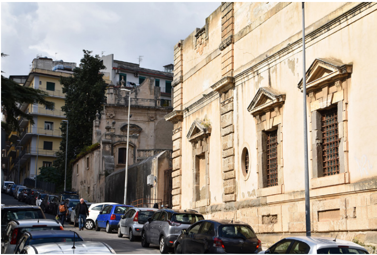
Fig. 3. Messina, Monte di Pietà. Prospetto est (foto E. Pennestrì 2023).
