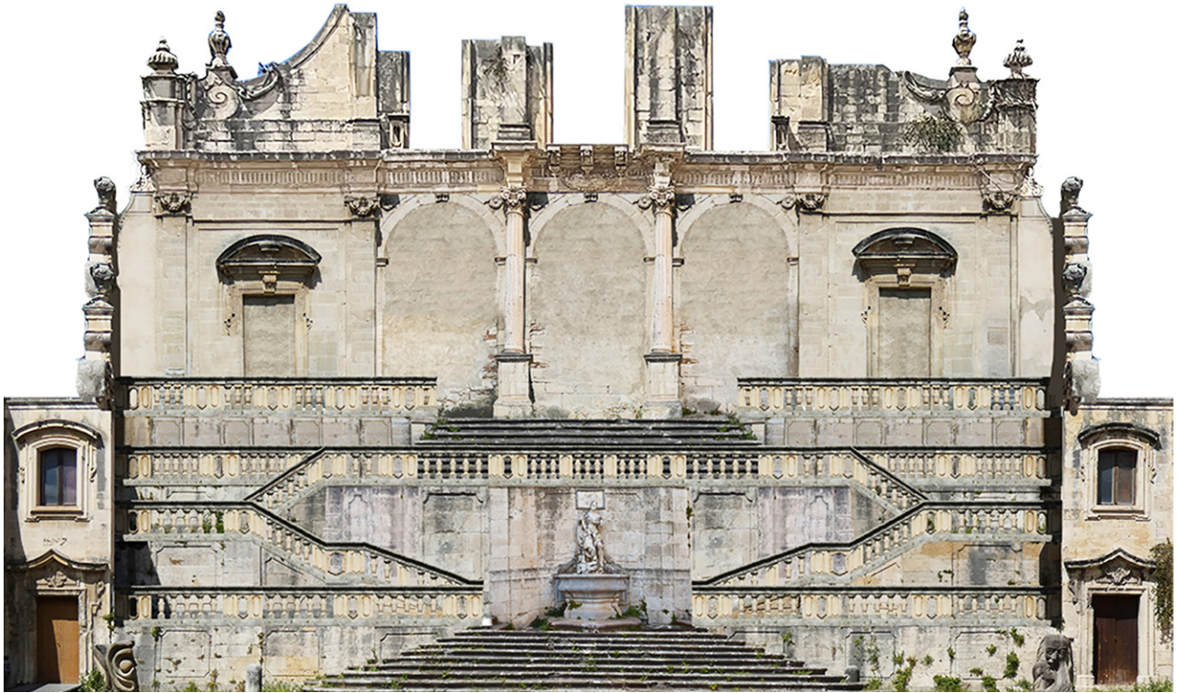
Fig. 4. Messina, Monte di Pietà. La corte con la scalinata e la facciata 'consolidata' della chiesa di Santa Maria della Pietà.
