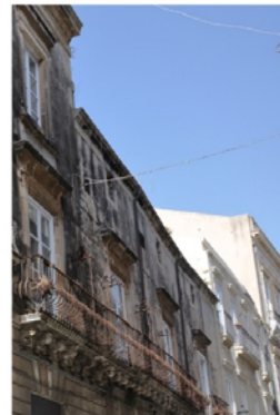
Figura 52 Esempificazione degli elementi localizzati sulla mappa delle vulnerabilità e resistenze: disallineamento delle aperture in facciata (sx), allargamento apertura al piano terra (cent), disallineamento degli orizzontamenti (dx).
