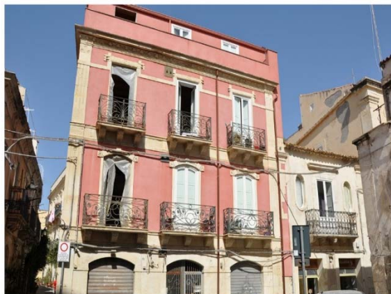
Figura 51 Esemplificazione fotografica degli elementi localizzati sulla mappa delle vulnerabilità e resistenze: corpi svettanti (sx), sopraelevazioni parziali (dx).
