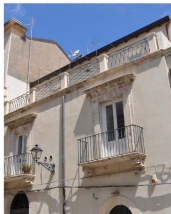
Figura 51 Esemplificazione fotografica degli elementi localizzati sulla mappa delle vulnerabilità e resistenze: corpi svettanti (sx), sopraelevazioni parziali (dx).
