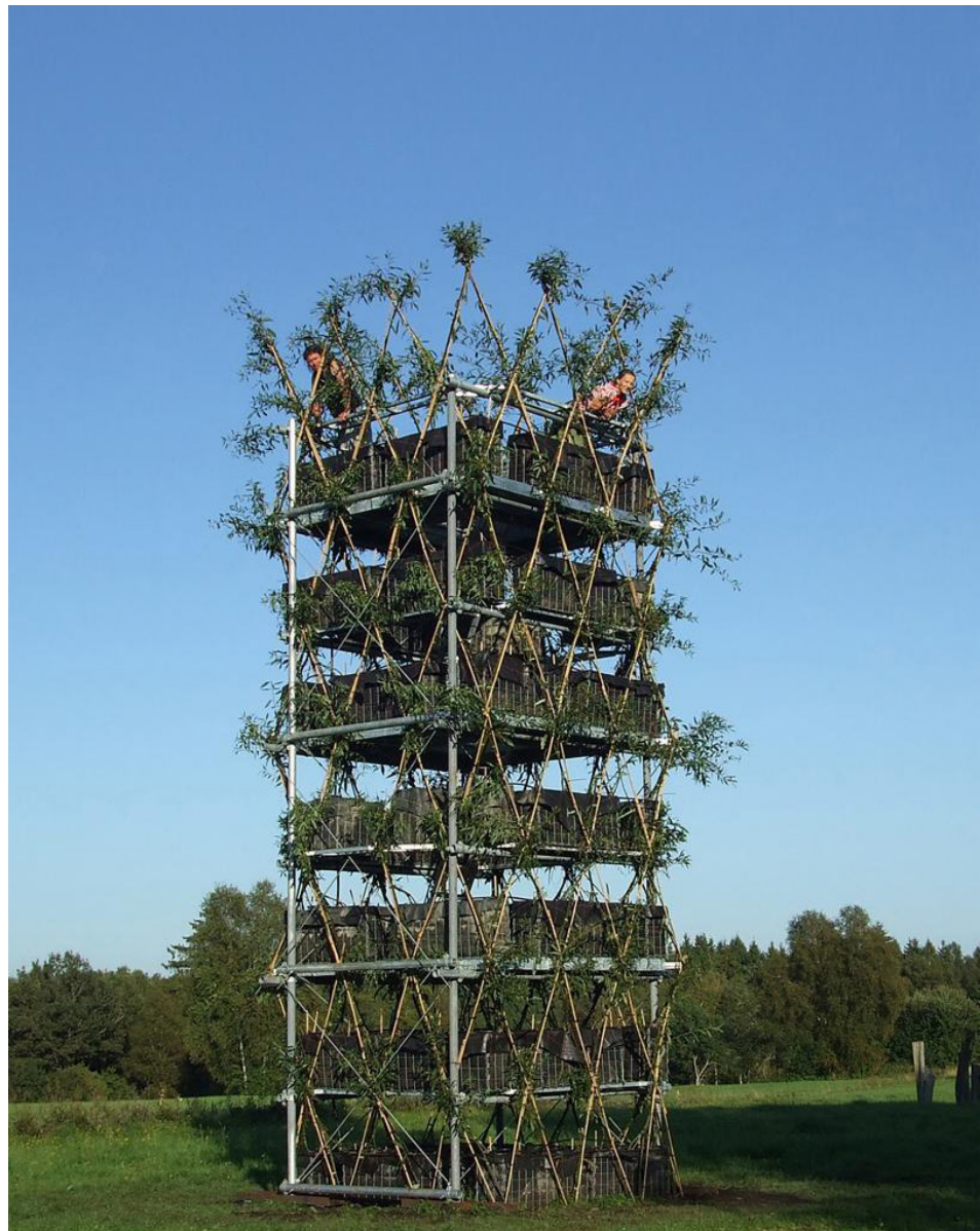
Fig. 15. Project Baubotanik Tower Experimental structure Wald-Ruhestetten, GER.2009. Design: Ferdinand Ludwig mit Cornelius Hackenbracht
