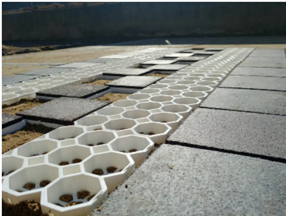
Fig. 32. Dettaglio del sistema di drenaggio del Green Parking per gli scenari PVC UpCycling. (fonte: elaborazione PMopenlab, 2019)
