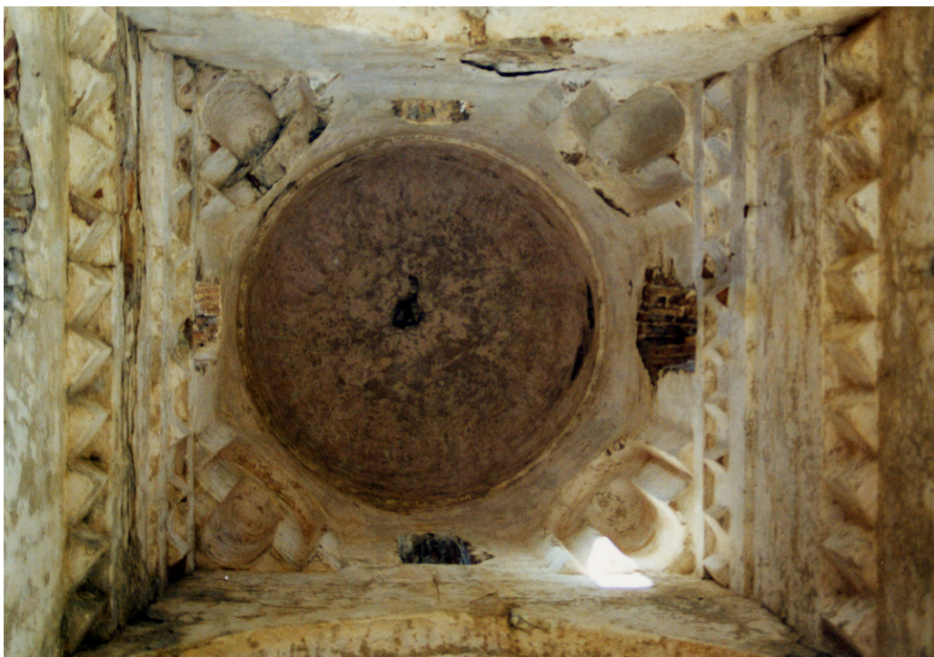
Fig. 4. San Giovanni Theristis (San Giovanni Vecchio), Bivongi, XI-XII secolo. Vista dal basso della cupola (prima del restauro). Foto dell'autore.
