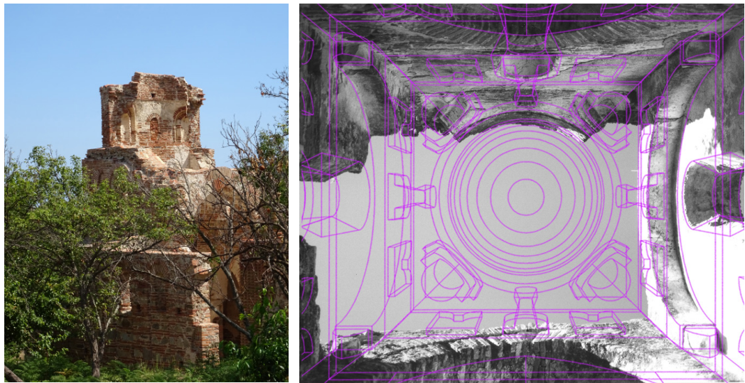
Figg. 7, 8. Santa Maria de' Tridetti, Staiti, XI-XII secolo. A sinistra: vista del moncone della cupola da nord-ovest. A destra: vista iposcopica della cupola con sovrapposizione dell'ipotesi di configurazione originaria. Foto ed elaborazione dell'autore.
