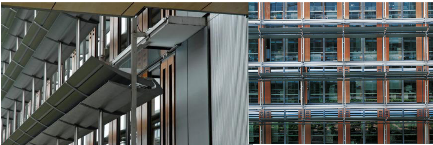
Fig. 1 - Involucro interattivo. L'edificio per uffici a Wiesbaden, Germania (progetto Thomas Herzog & Partner)/Interactive Envelope. The office building in Wiesbaden, Germania (Thomas Herzog & Partner) (Source: infobuildenergia.it).
