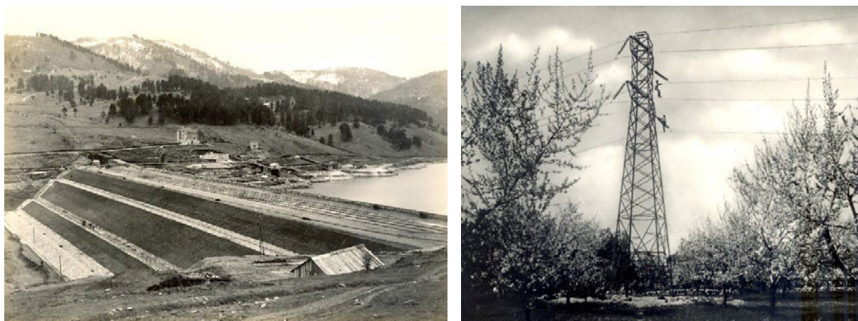
Figg. 1-2. (a sinistra) Il lago Arvo con la diga di Nocella durante la realizzazione (foto: Archivio Storico ENEL di Napoli); (a destra) Linea 150 kV Sila-Puglia (foto: Archivio Storico ENEL di Napoli).
