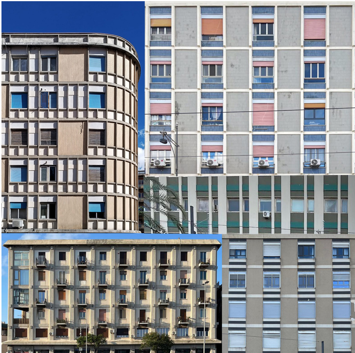
Fig. 5. Edifici con facciata definita da elementi strutturali complanari (foto dell'autrice).
