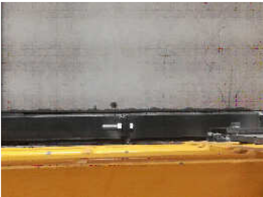
Fig. 34 - Infiltrazioni di acqua durante la simulazione del test in presenza di vento / Water infiltration during the test simulation in presence of wind (Source: Authors' elaboration).
