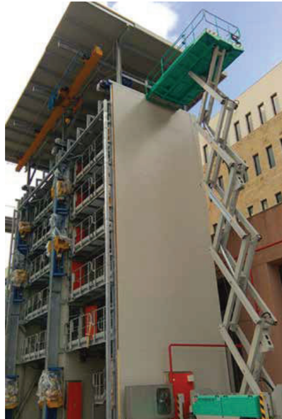
Figura 03 – Test Lab per facciate del TCLab Testing Envelope dell'Università Mediterranea di Reggio Calabria.
