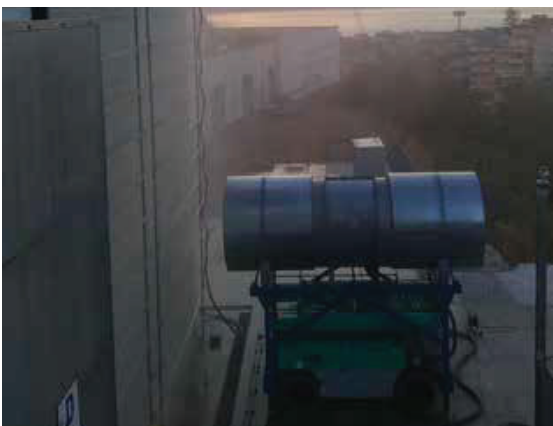
Figura 06 – Esecuzione di prova su mock-up di facciata.
