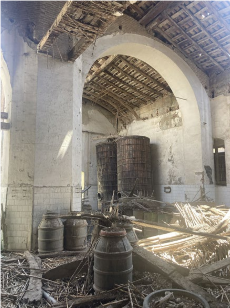
Figura 21. Roccalumera (Me). Lo stabilimento per la trasformazione delle essenze agrumarie ex Speda, abbandonato negli anni Ottanta del Novecento (foto dell'autore, 2023).
