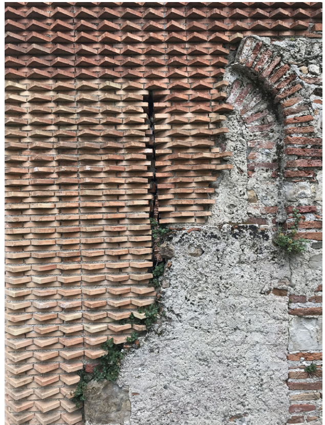
Fig. 4. Staiti (RC), Santa Maria dei Tridetti. Particolare dell'integrazione muraria (foto N. Sulfaro 2023)
