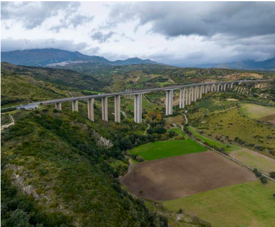
Fig. 87-88 P. Iaonantonio, Vedute Viadotto Salso 2023
