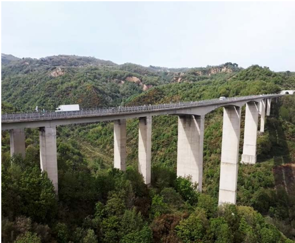
Fig. 93-94, Vedute Viadotto Stupino 2023
