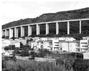
Viadotto Costiera di Pizzo 10
