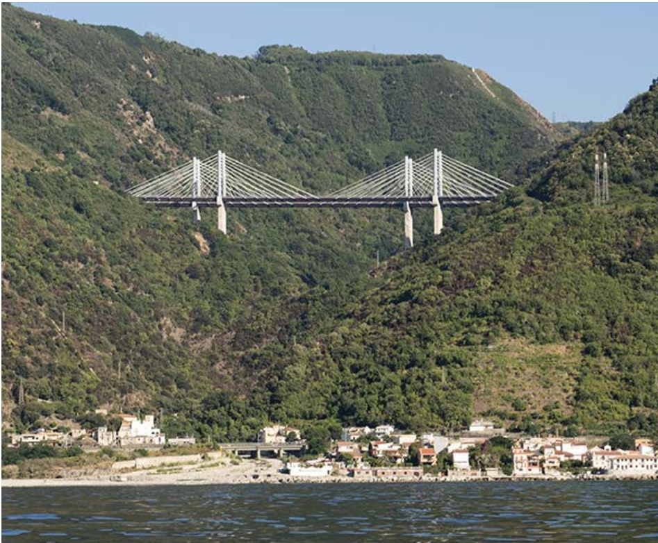
Fig. 107-108 Archivio WeBuild, Vedute Viadotto Favazzina 2023
