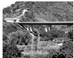
Viadotto Fiume Grande 9
