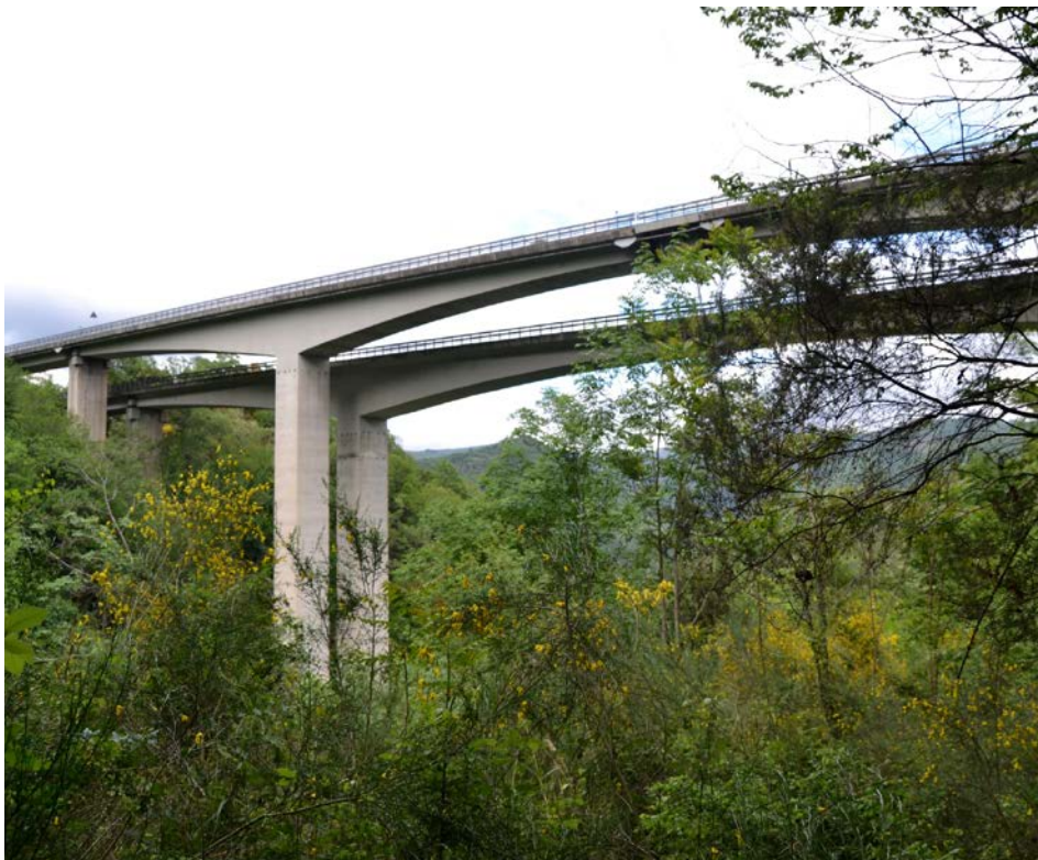
Fig. 96-97, Vedute Viadotto Ruiz 2023
