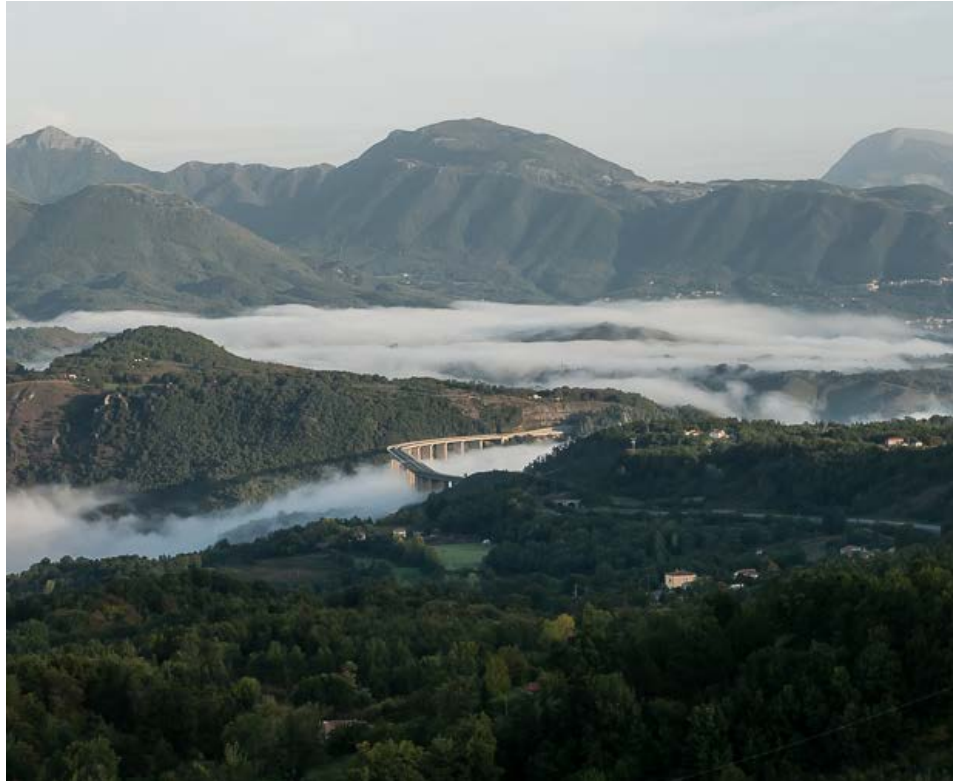
Fig. 44 F. Cornicello, Veduta del viadotto Italia sul fiume Lao. 2014
