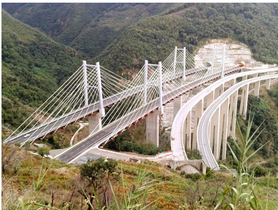
Fig. 65 Archivio ANAS, Adeguamento dell'Autostrada Viadotto Favazzina 2013
