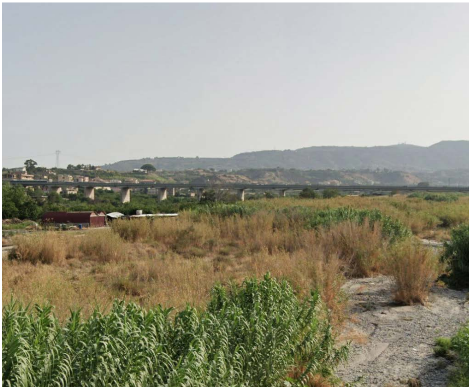
Fig. 110-111, Vedute Viadotto F. di Catona 2023
