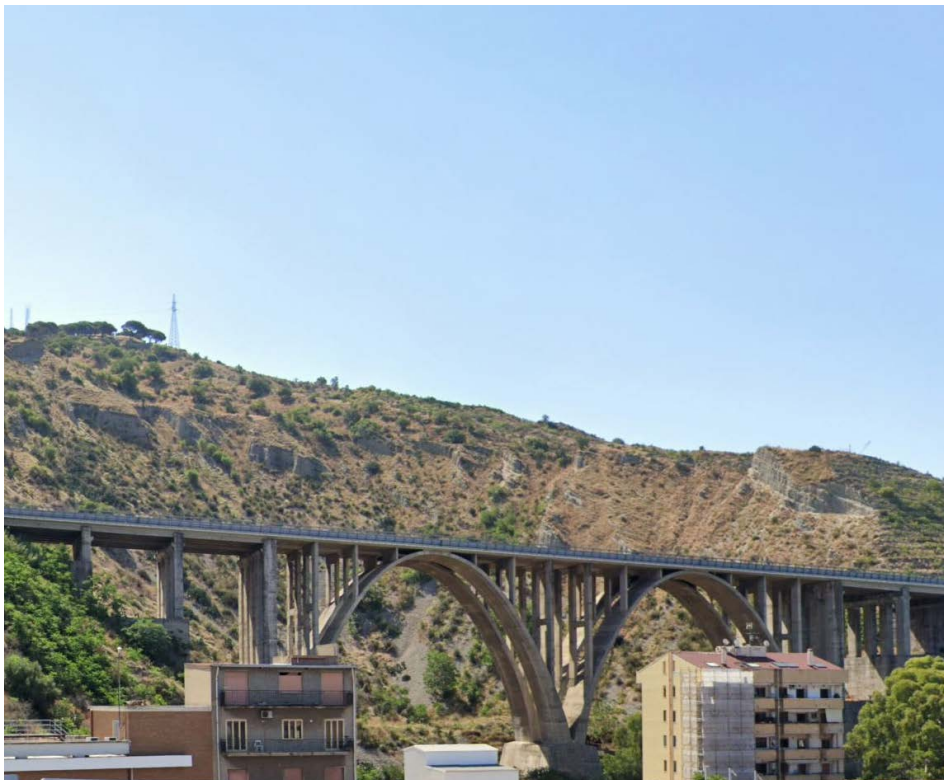
Fig. 116-117 Vedute Viadotto Torbido 2023
