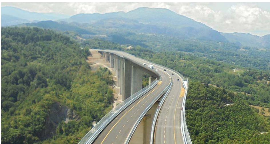
Fig. 67 Archivio ANAS, Adeguamento dell'Autostrada Viadotto Italia 2016
