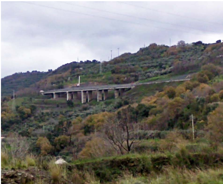
Fig. 99-100, Vedute Viadotto Ruiz 2023
