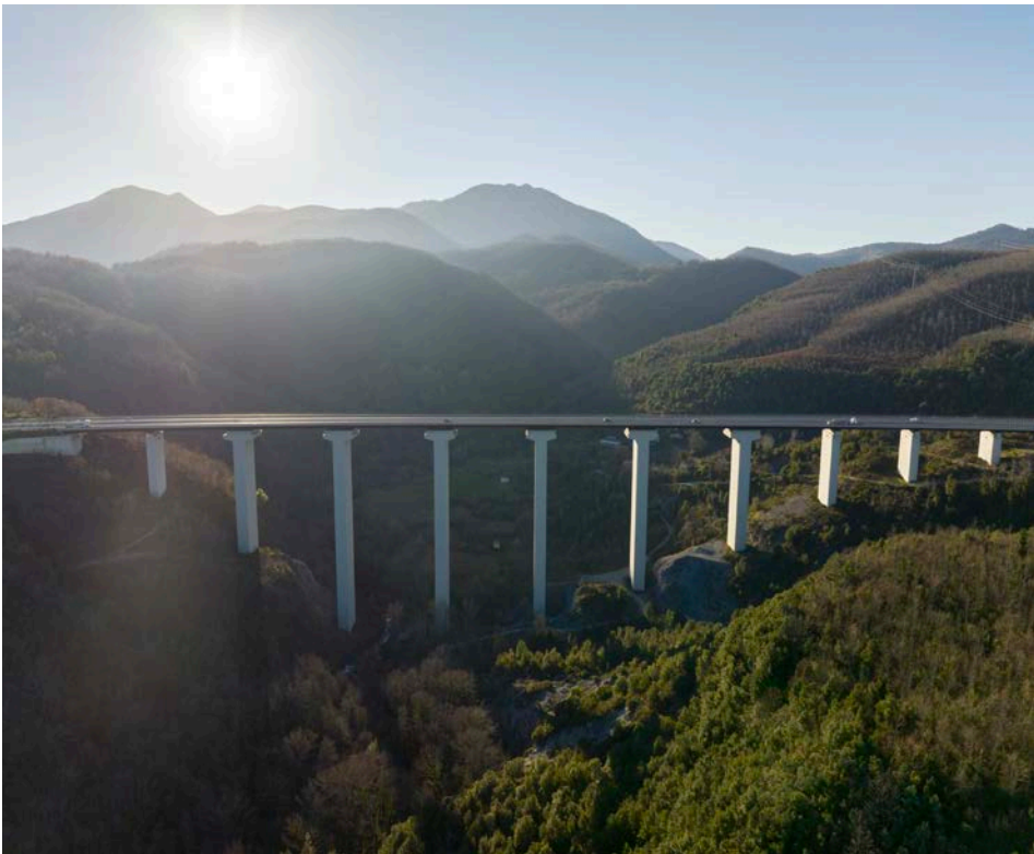
Fig. 75-76 P. Iaconantonio, Vedute Viadotto Jannello 2023
