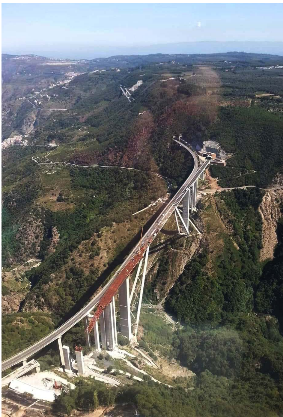
Fig. 69 Archivio ANAS, Adeguamento dell'Autostrada Viadotto Sfalassà 2010
