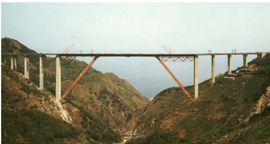
Fig. 63 G. Chioloni, Fasi costruttive del Viadotto Sfalassà, Fondo IN.CO. S.p.A. e Silvano Zorzi, 1968-1972
