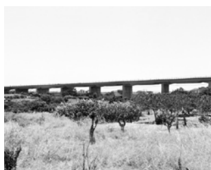
Viadotto Fiumara di Catona 13
