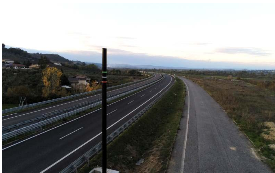
Fig. 71 Archivio ANAS, Infrastrutture smart road lungo l'Autostrada del Mediterraneo 2022
