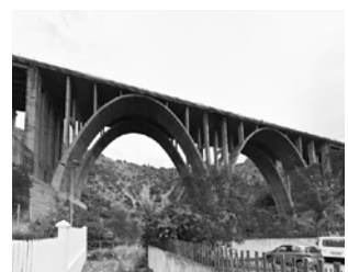
Viadotto Cava Leone 15
