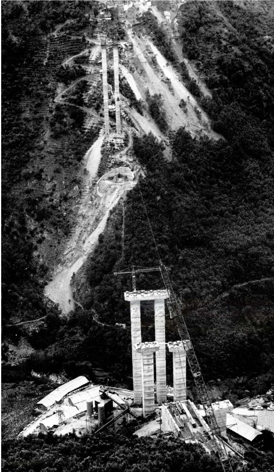
Fig. 52 Touring Club Italiano, Sfalassà Autostrada SA-RC in costruzione, 1968
