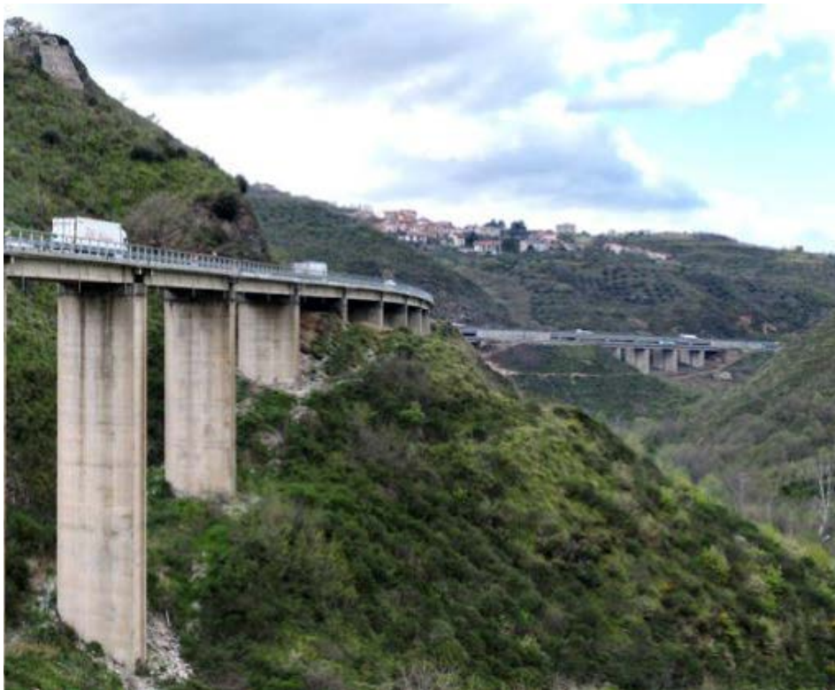
Fig. 90-91, Vedute Viadotto Friddiza 2023
