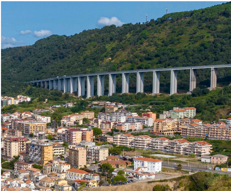
Fig. 102-103 P. Iaonantonio, Vedute Viadotto Costiera di Pizzo 2023
