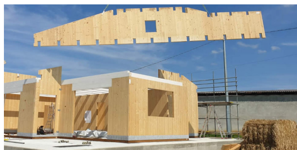
Costruzione in cross-lam http://www.bioediliziasardegna.com/tecniche.php?page=1
