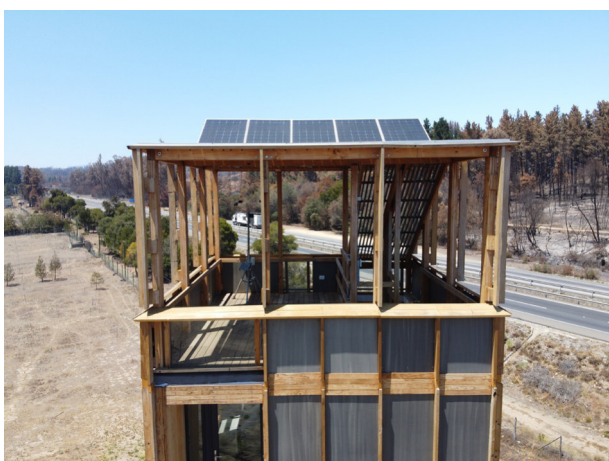
Terrazzo Torre Peñuelas. Foto realizzata dall'autore con l'ausilio di un drone.
