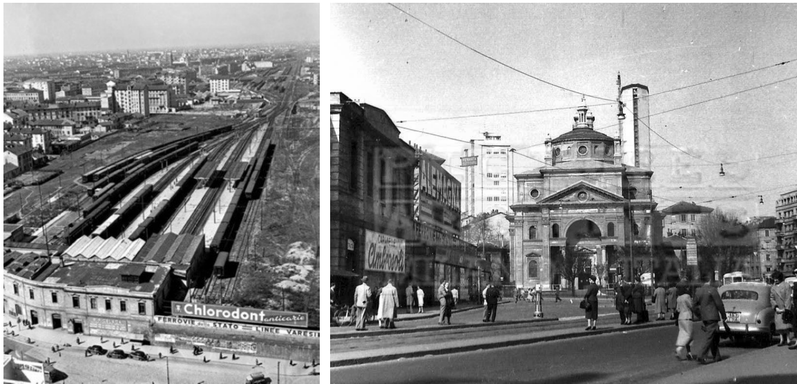
Fig.3. A sinistra la stazione Varesine nel 1950, a destra, la stazione delle Varesine e chiesa di San Gioacchino con il Pirelli in costruzione sullo sfondo. (fonte: Blog Urbanfile https://blog.urbanfile.org/2014/07/09/zona-porta-nuova-la-storia-di-un-area-e-le-sue-trasformazioni-capitolo-1-porta-nuova-e-le-origini/ )
