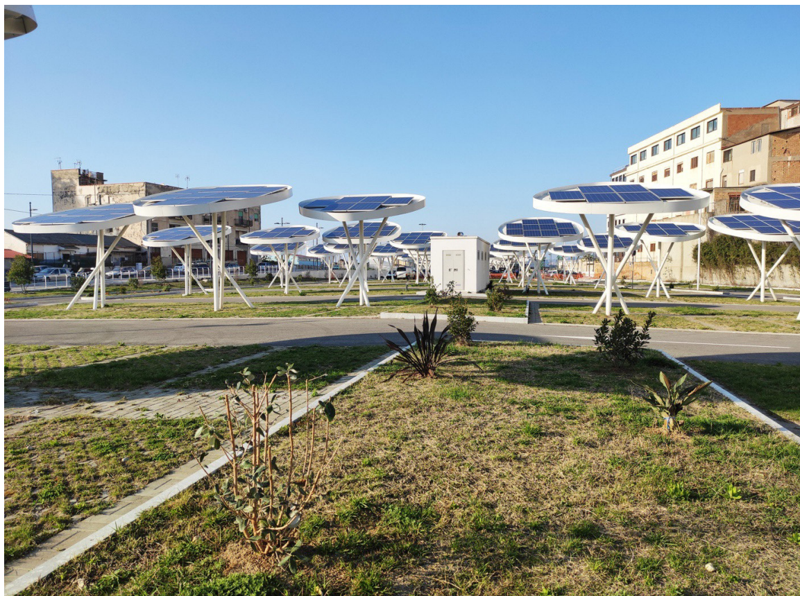
Fig.49. Un’immagine notturna della Pineta Zerbi illuminata con i sistemi a Led in cui è ben visibile la strategia adottata per separare definitivamente l’area pedonale da quella carrabile.
