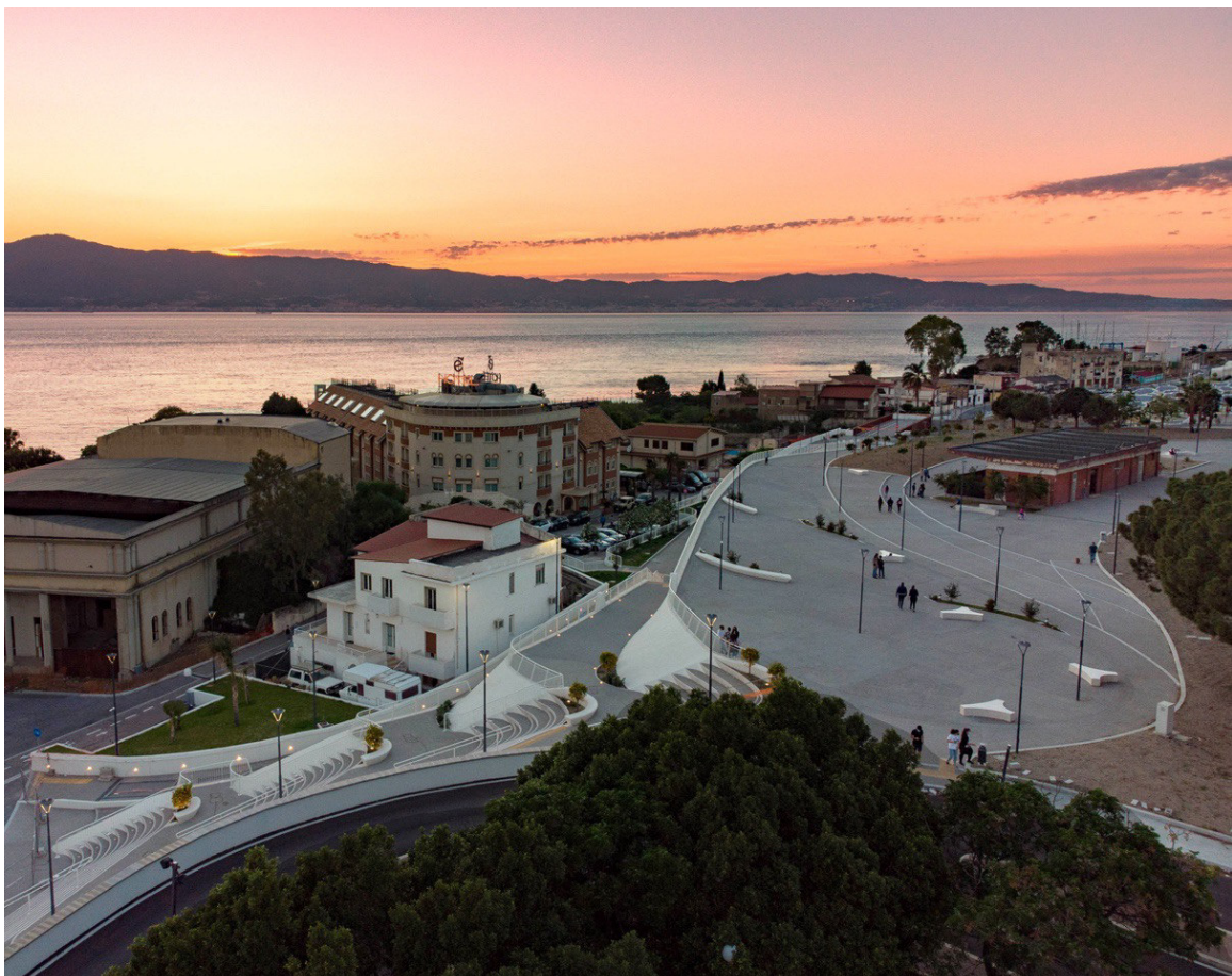
Fig.45. Una fotografia aerea della scalinata che si raccorda con la passeggiata del lungomare alto e quello basso.
