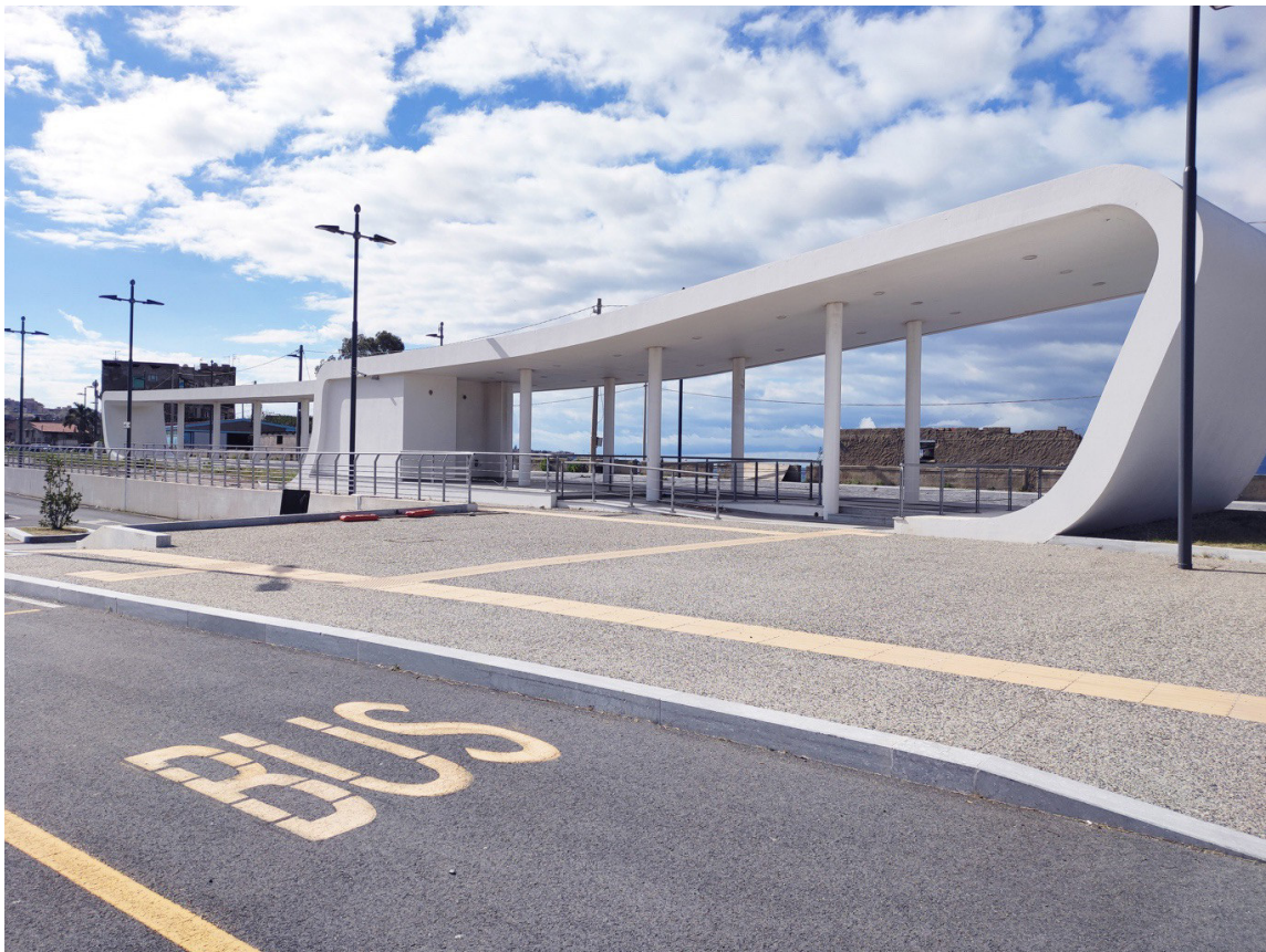
Fig.48. Una fotografia del terminal bus.
