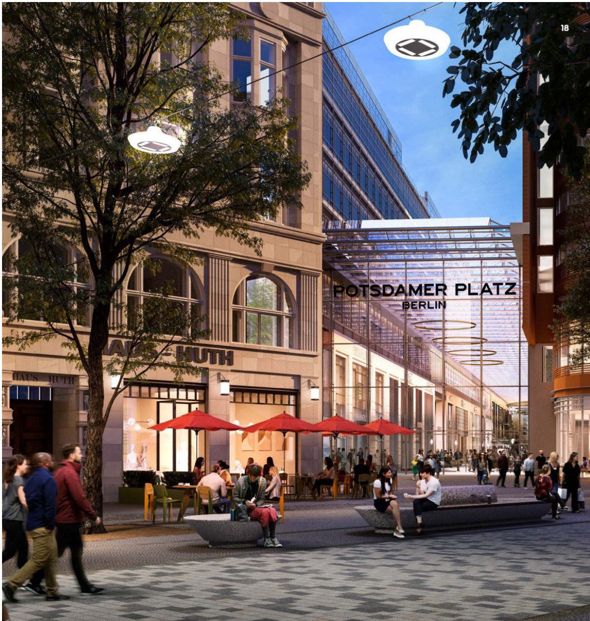
Fig.41. Una vista di come sarà l'area una volta ultimati gli interventi di ristrutturazione.
