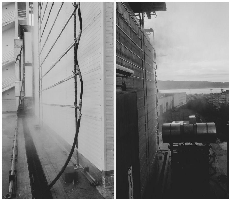
Fig. 11. Impianto griglia sprinkler progettato secondo normative UNI - AAMA presso la sezione TCLab del Building Future Lab (Reggio Calabria)
