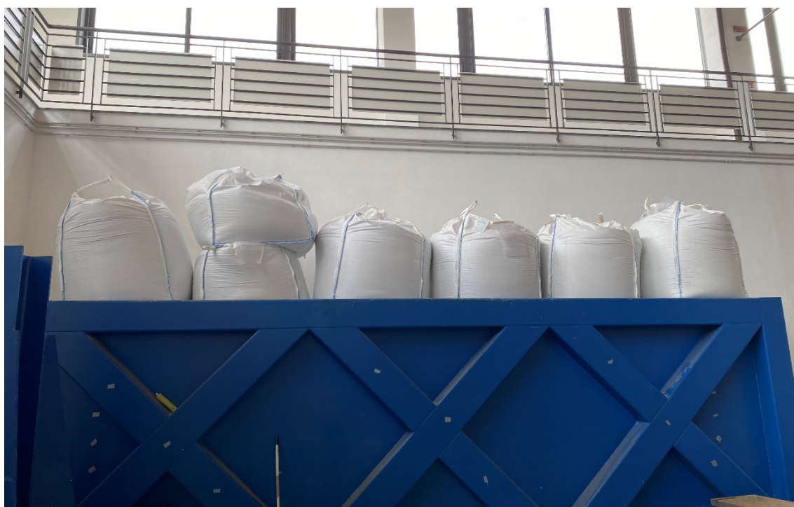
Figura 5.30 Big-bag predisposte per il riempimento della tramoggia
