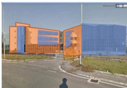
Figura 51_ Facciate Sud ed Est edificio.
