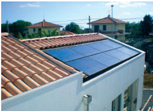
Figura 30_ Casa Mascalucia (Progetto Botticelli): pannelli solari.
