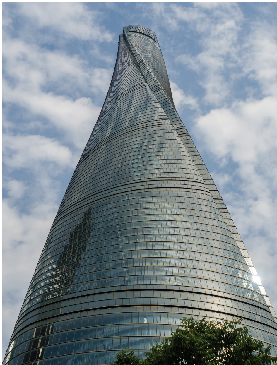
Fig. 2.2 Shanghai Tower. Fonte: Bonham, M. B., 2020.
