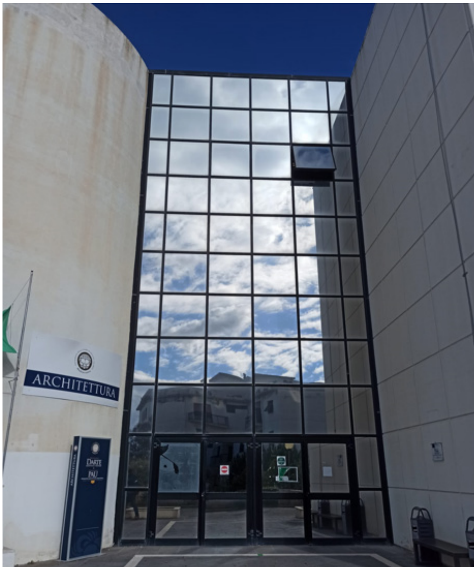
Fig. 3.4 Fotografia della facciata d'ingresso B.
