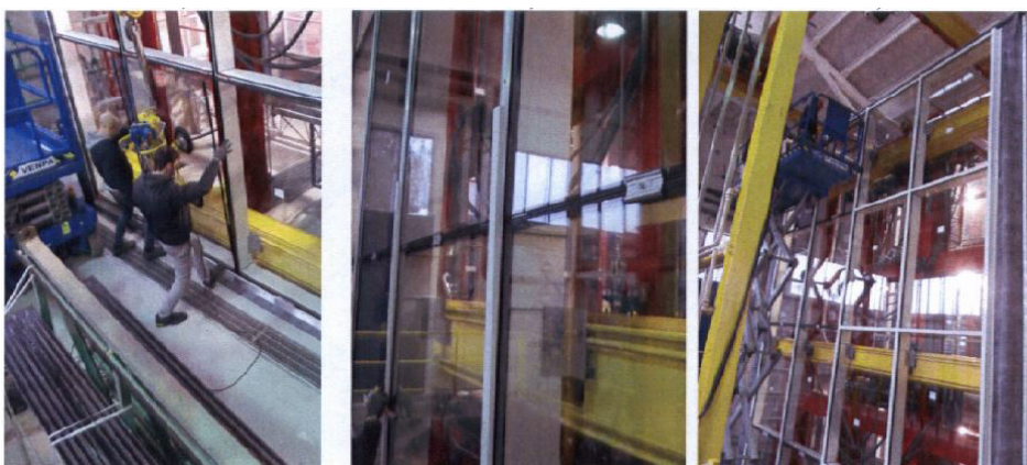
Fig. 4.47 Fasi salienti del posizionamento del campione sull'apparecchiatura di prova. Installazione lastre di vetro, posa di coprigiunti ed altri elementi di completamento, completamento facciata. Fonte: Relazione tecnica Metra.
