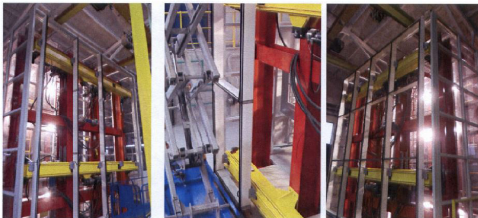
Fig. 4.46 Fasi salienti del posizionamento del campione sull'apparecchiatura di prova. Montaggio montanti, traversi e reticolo montanti-traversi. Fonte: Relazione tecnica Metra.
