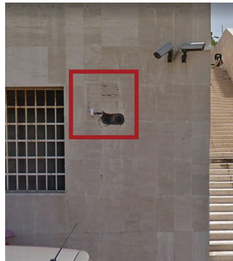
Fig. 2.5 Indagini in situ: prelievo di lastre di una fase successiva all'originaria posa in opera, probabilmente riferibile alla ricostruzione post-bellica.
