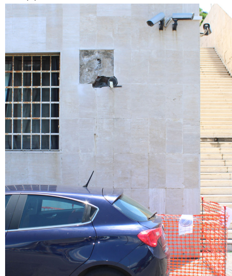
Fig. 2.4 Indagini in situ: lastra, individuata nel gruppo dei moduli dismessi, riferibile alle Manutenzioni LDO/LDV (campione serie H). Spessore di 2 cm, piuttosto che 3 cm, e doppio strato di allettamento
