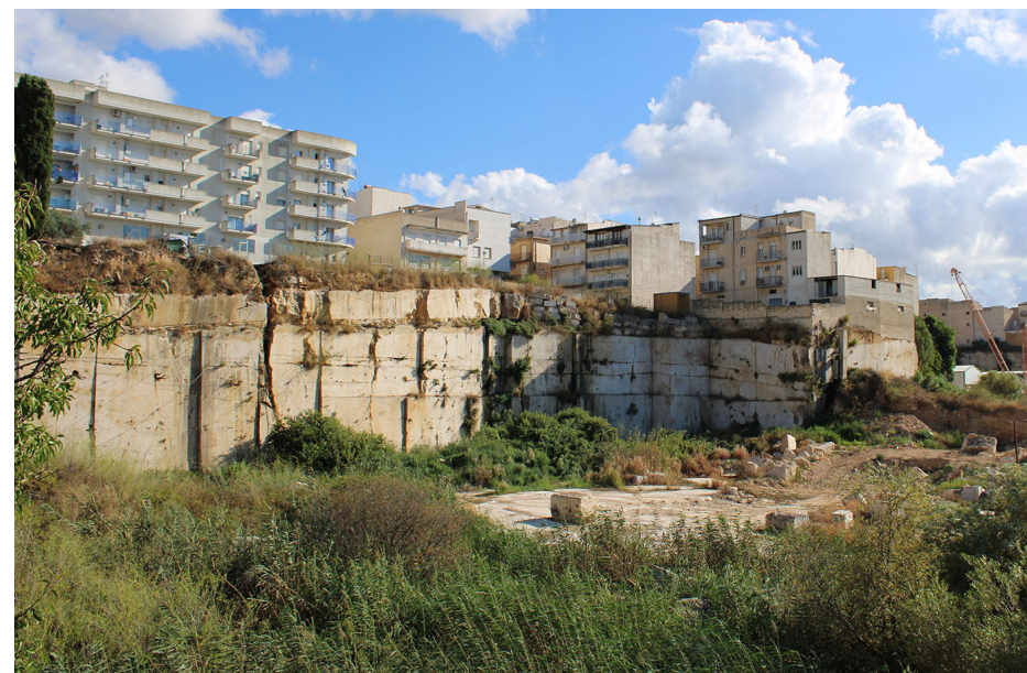
Fig. 2.6 Alcamo (TP), il centro abitato a ridosso del fronte di cava in zona Gammara (nota anche con la denominazione Fontana della Pietra).
