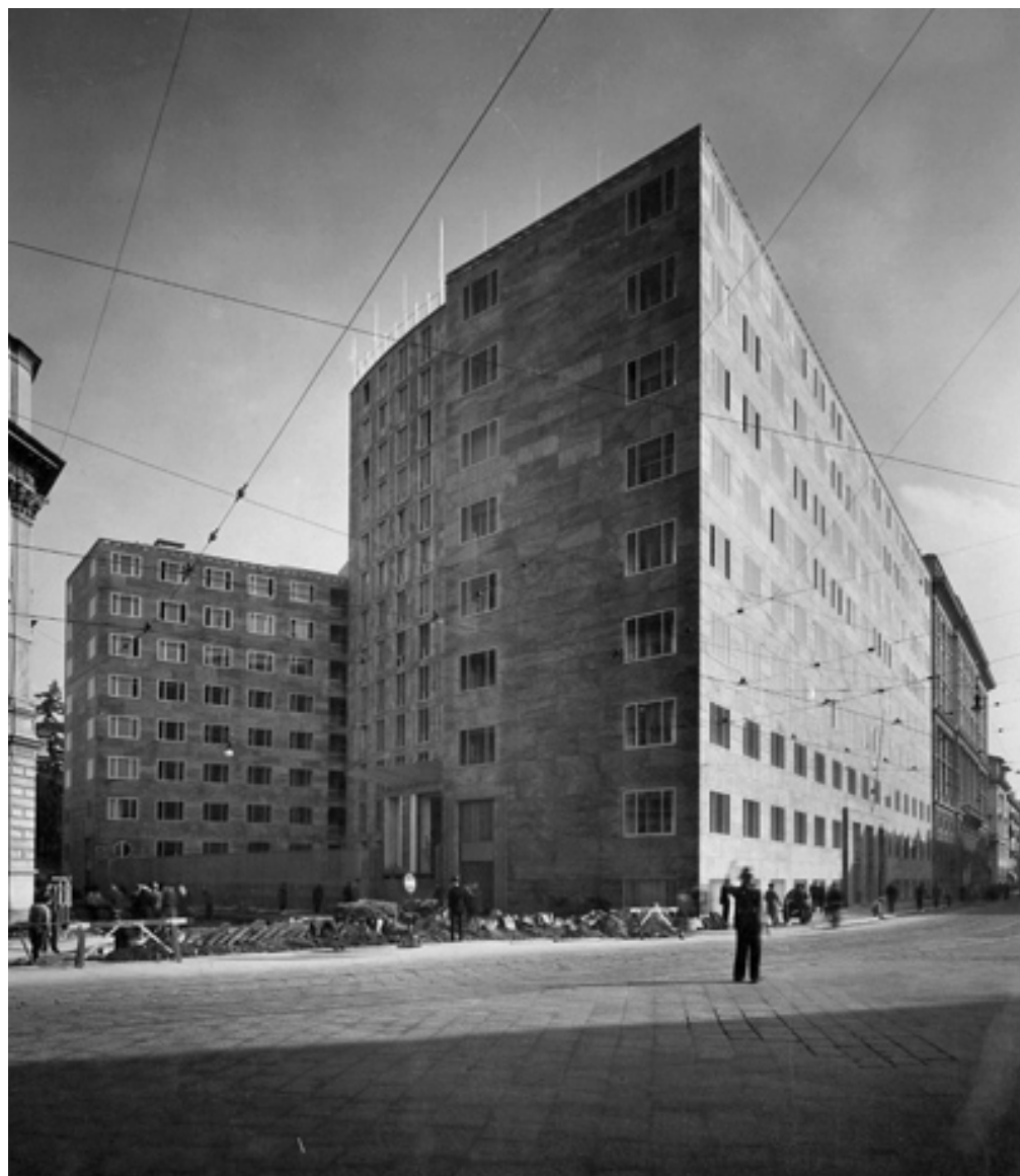
Fig. 1.14 Palazzo Montecatini di Gio Ponti a Milano, 1936: i dettagli tecnico-costruttivi del rivestimento in lastre di Cipollino messe in opera con imbottitura di malta di cemento e ancoraggi metallici (olivari.it; Biella, 1939, p. 124).
