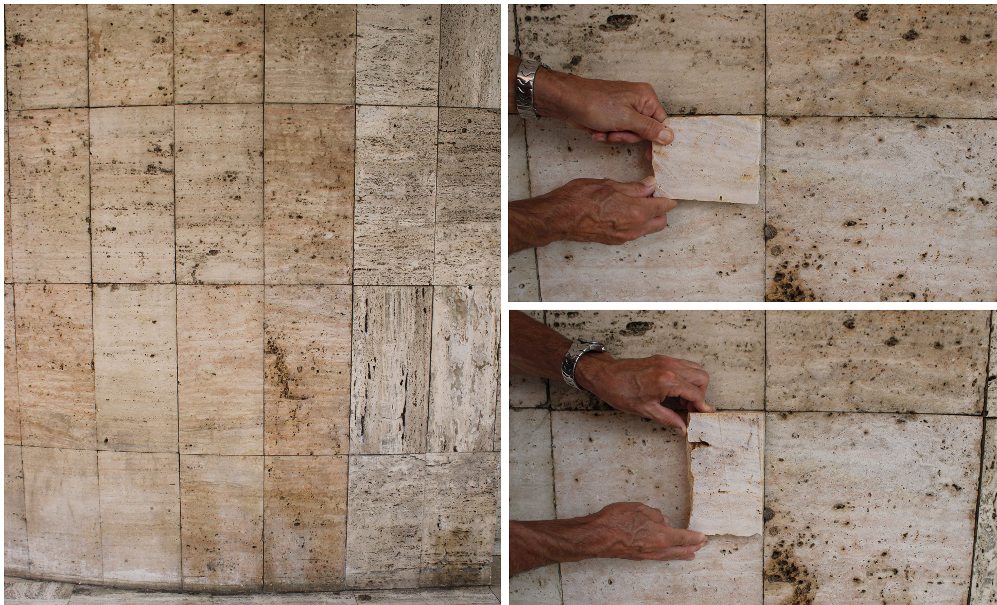
Fig. 2.10 Confronto dei provini ricavati dal campione di cava dei f.lli Gatto con le lastre del rivestimento del Fabbricato Viaggiatori della Stazione Centrale di Messina.
