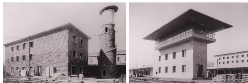
Fig. 2 Il complesso ferroviario: il Fabbricato Viaggiatori della Stazione Marittima; il Fabbricato Viaggiatori della Stazione Centrale; le Regie Poste e il Fabbricato Uffici; Fabbricato IES e il Rifornitore per Acqua; la Cabina Apparati Centrali
