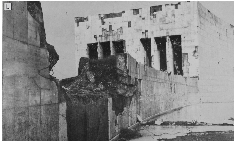
Fig. 2.27a Il prospetto con accesso alla sala della Stazione Marittima e le semivolte del sovrappassaggio pedonale demolite in occasione della ricostruzione post-bellica. Dalla costruzione originaria (a: MART, Maz.G3.55.X), ai danni della Seconda Guerra Mondiale (b, c: FS Compartimento di Palermo, 1947, pp. 3, 14), a oggi.
