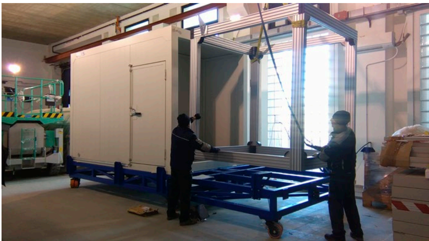
02 | Fase di montaggio della Test Cell, archivio BFL, foto di Martino Milardi Assembling of Test Cell, BFL archive, photos of Martino Milardi
