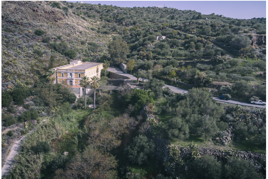
Fig. 1: L'area dello stabilimento termale di San Calogero (foto Cristina Mollica, 2018).
