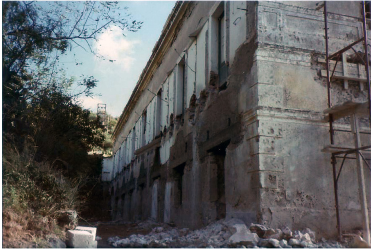
Fig. 16: Demolizione dei bagni posti sulla facciata nord. Successivamente saranno ampliati i vani che prima fungevano da finestre, e diventeranno punti di passaggio tra il vecchio ed il nuovo corpo di fabbrica (archivio F. Scappin).
