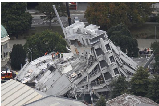
Fig. 9. Christchurch, Nuova Zelanda. Conseguenze del terremoto del 22 febbraio 2011.
