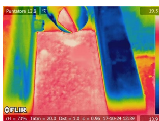
fig. 29-b. Analisi Termografica Canale di Adduzione.
