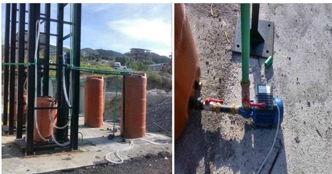
Figura 7.14: a) Collegamenti del serbatoio di monte b) pompa di alimentazione del serbatoio di monte da
