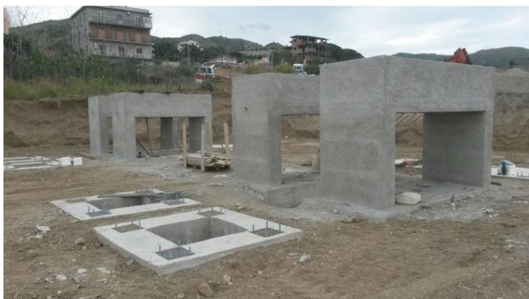
Figura 7.9: Completamento delle opere in cemento armato
