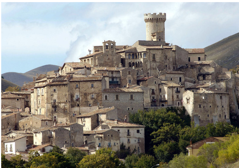
46 Vista panoramica borgo St. Stefano di sessanio
