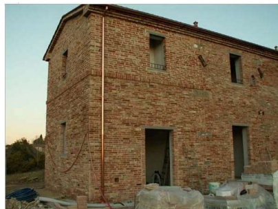
Figura 9. Struttura in muratura 22
