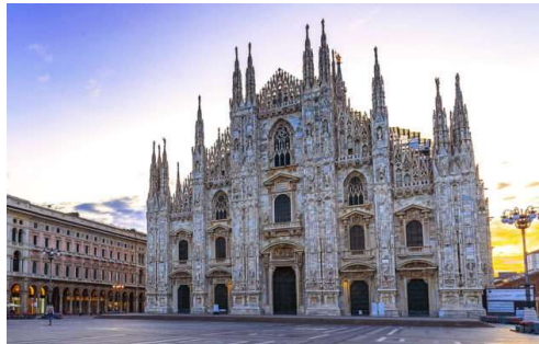
Figura 10. Facciata del duomo di Milano, stile gotico.
