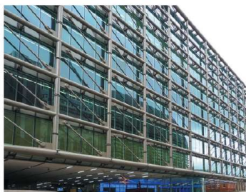
Figura 11. Facciata con elementi di controventatura di dimensioni minori rispetto allo scheletro dell'edificio.
