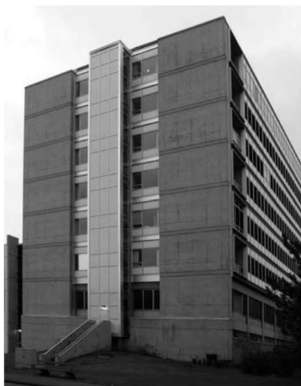
Figura 2. Edificio a Vancouver rinforzato con pareti sismiche. 7
