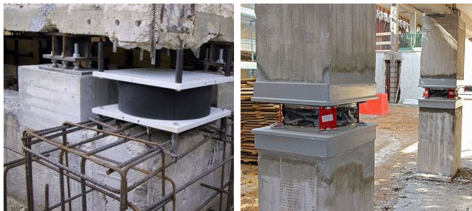
Figura 5. Esempi di isolamento sismico alla base
