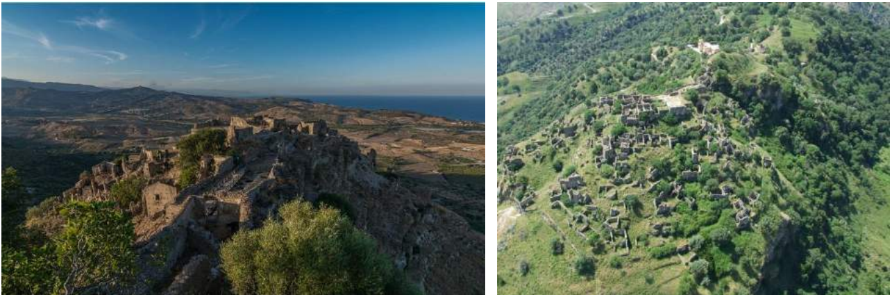
Figg. 1 e 2 – Brancaleone Vetus (Calabria, Italia). L'antico borgo fortificato, oggi abbandonato e allo stato di rudere (foto Saverio Corigliano).
