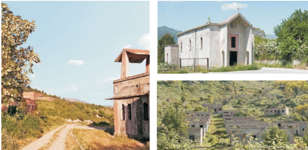
Figura 3. Villaggio di Schisina, Francavilla di Sicilia (Messina) nello stato attuale; a) ingresso al borgo Morfia; b) Piano Torre (la chiesa), c) San Giovanni (vista delle abitazioni) (foto F. e G. Romano, 2014).
