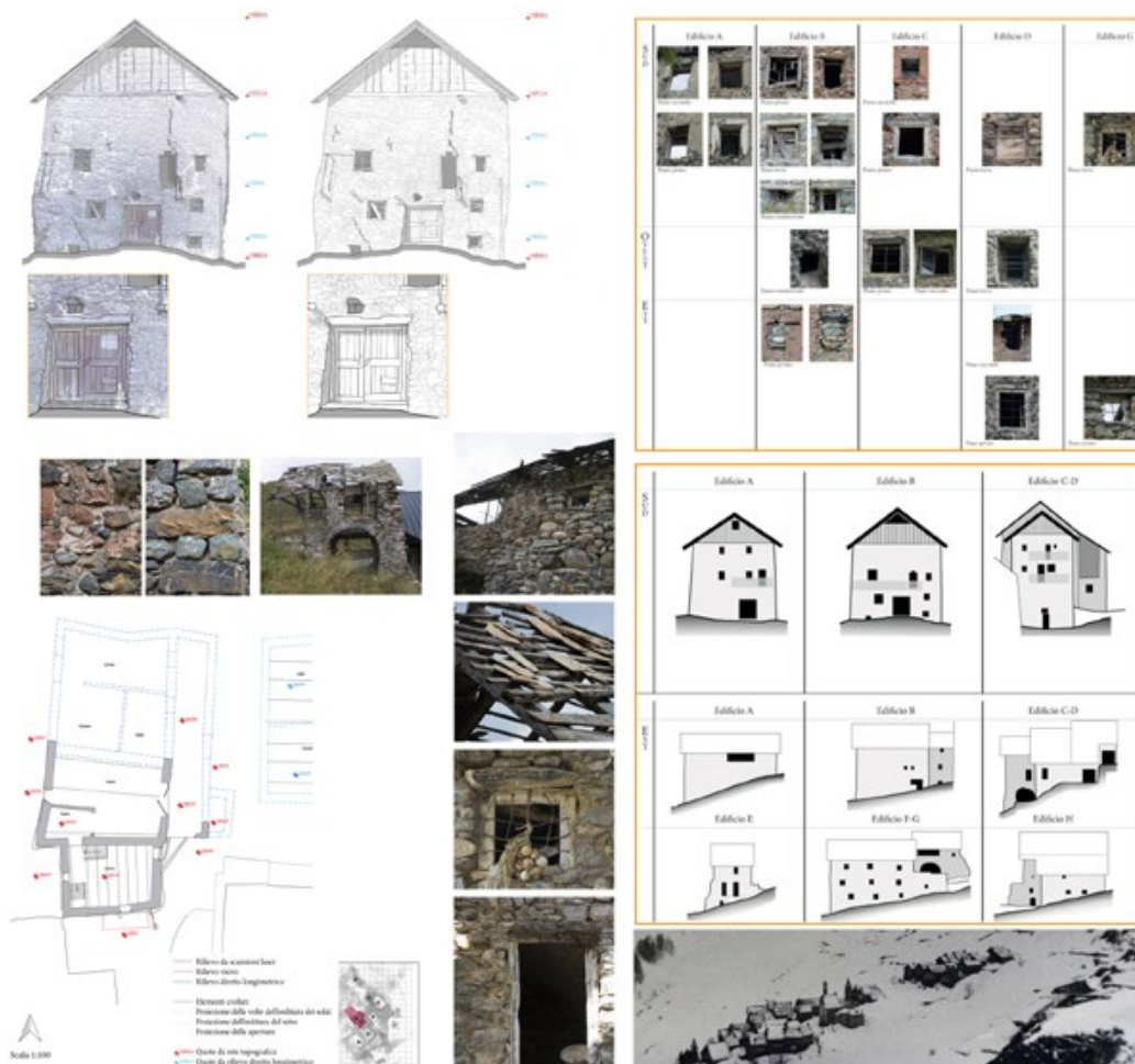
Figura 7. Lettura e interpretazione dei sistemi costruttivi e degli elementi architettonici (murature, sistemi di copertura, solai e volte, aperture, serramenti, ecc.) a partire dal rilievo laser scanning che ha consentito la completa restituzione di piante prospetti e sezioni degli organismi edilizi della borgata. Gli abachi di sintesi sono indirizzati alla formulazione dei manuali di buone pratiche per il recupero. In basso a destra un'immagine degli anni Settanta di Ferriere prima dell'abbandono e declino della borgata alta (collezione Rovere) (elaborazione di F. Calcagno Tunin, S. Cerise, tesi di laurea, 2017).
