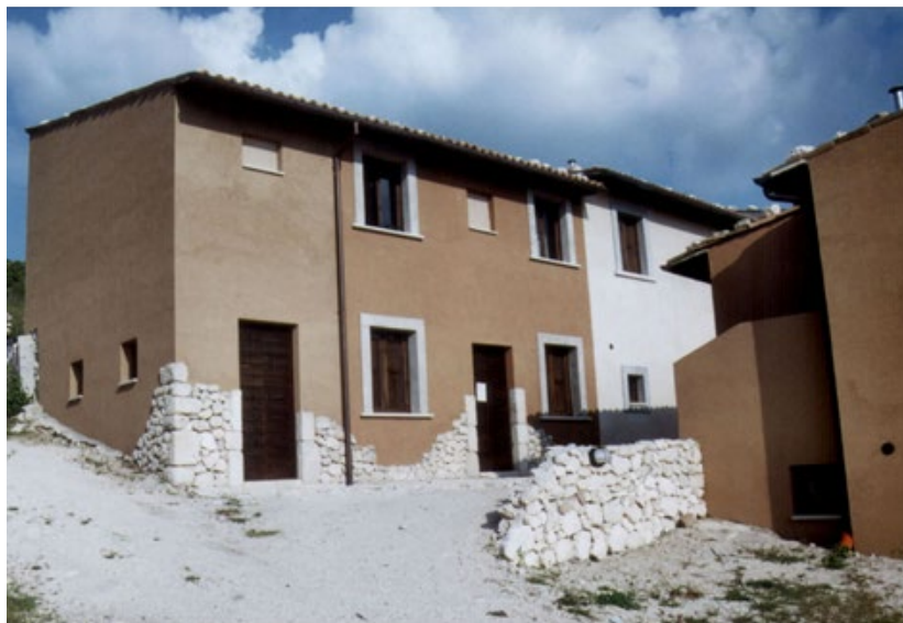
Figura 7a-b. Albe Vecchia (L'Aquila). Alcuni esempi di ricostruzione degli edifici ridotti a rudere, che giocano sul contrasto tra le antiche murature e i nuovi inserti (foto C. Varagnoli, 2006)
