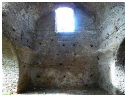
Fig. 6 - Bovalino (RC). Un ambiente voltato del fronte settentrionale del castello.
