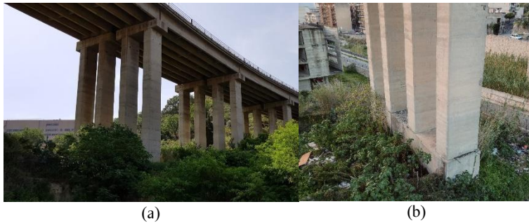
Figura 5.7 - (a) Struttura del viadotto, (b) base delle colonne
