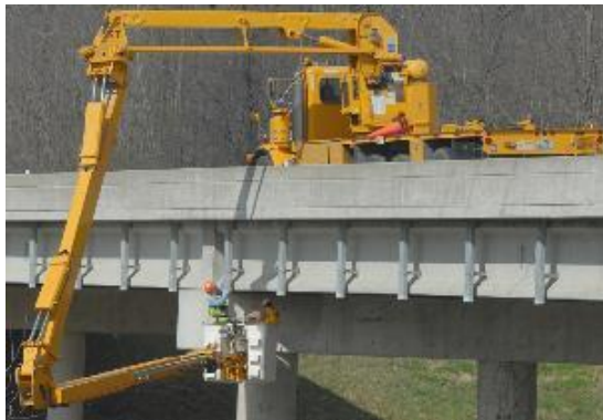
Figura 3.1 - Ispezione visiva eseguita con gru
