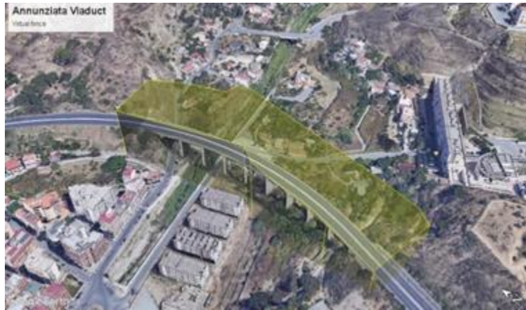
Figura 5.10 – Geo-Recinzione intorno al viadotto Annunziata per delimitazione dello spazio aereo per l'indagine.
