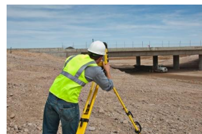
Figura 3.2 – Indagine sul ponte con Stazione totale (TS)
