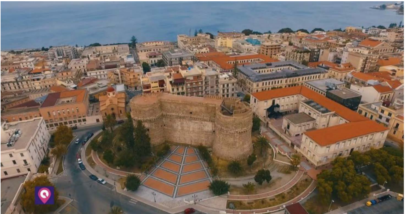
1: Il castello di Reggio Calabria nella sua configurazione attuale. La demolizione ha mantenuto solo le due torri quattrocentesche e il tratto di cortina di collegamento (foto citynow.it).
