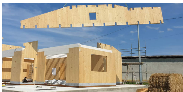
Costruzione in cross-lam http://www.bioediliziasardegna.com/tecniche.php?page=1
