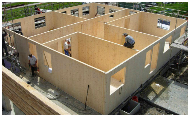
Edificio in fase di completamento, con sistema cross-lam. ( https://docplayer.it/50658050-Le-chiusure-verticali-opache.html )
