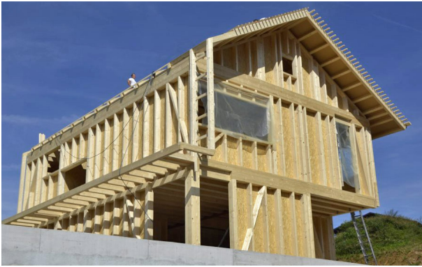
Edificio in fase di completamento con sistema costruttivo platform frame. https://www.zuerns.com/lumber-panels-engineered-wood/
