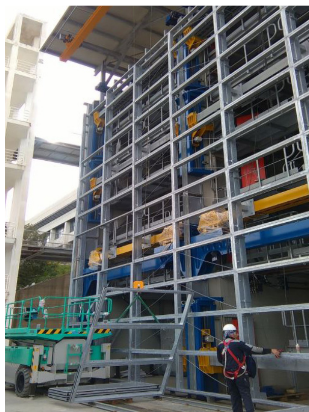
Installazione facciata continua da testare all'interno del modulo del TC-Lab. Immagine realizzata dall'autore.
