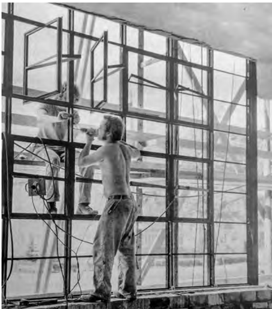
Curtain wall della sede del Bauhaus a Dessau, 1925.
