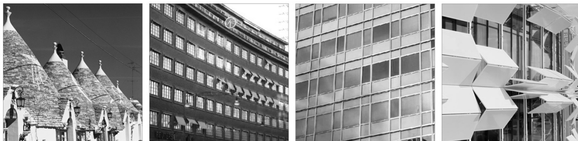
Fig. 2: Classificazione delle prestazioni energetiche dell'involucro. Da sx: Involucro conservativo (es. trulli); Involucro selettivo (es. intervento sui serramenti.); Involucro rigenerativo (es. sistema fotovoltaico integrato); Involucro eco efficiente (es. involucro dinamico ad assetto variabile)
