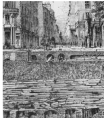
3-4. Da sinistra: boulevard Saint - Michel, 1853 - 1860, estremità meridionale del lungo asse di attraversamento nord - sud di Parigi; boulevard Richard Lenoir, 1861 - 1863, costruito sul canale Saint - Martin, attraversa i quartieri operai.
