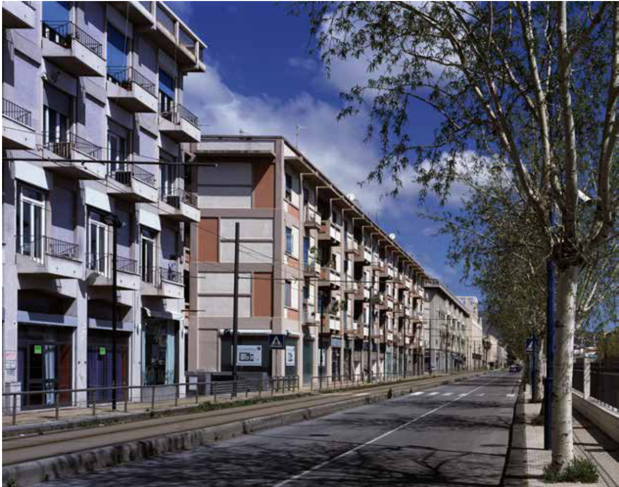
Isolato 5. Fronte a mare.
