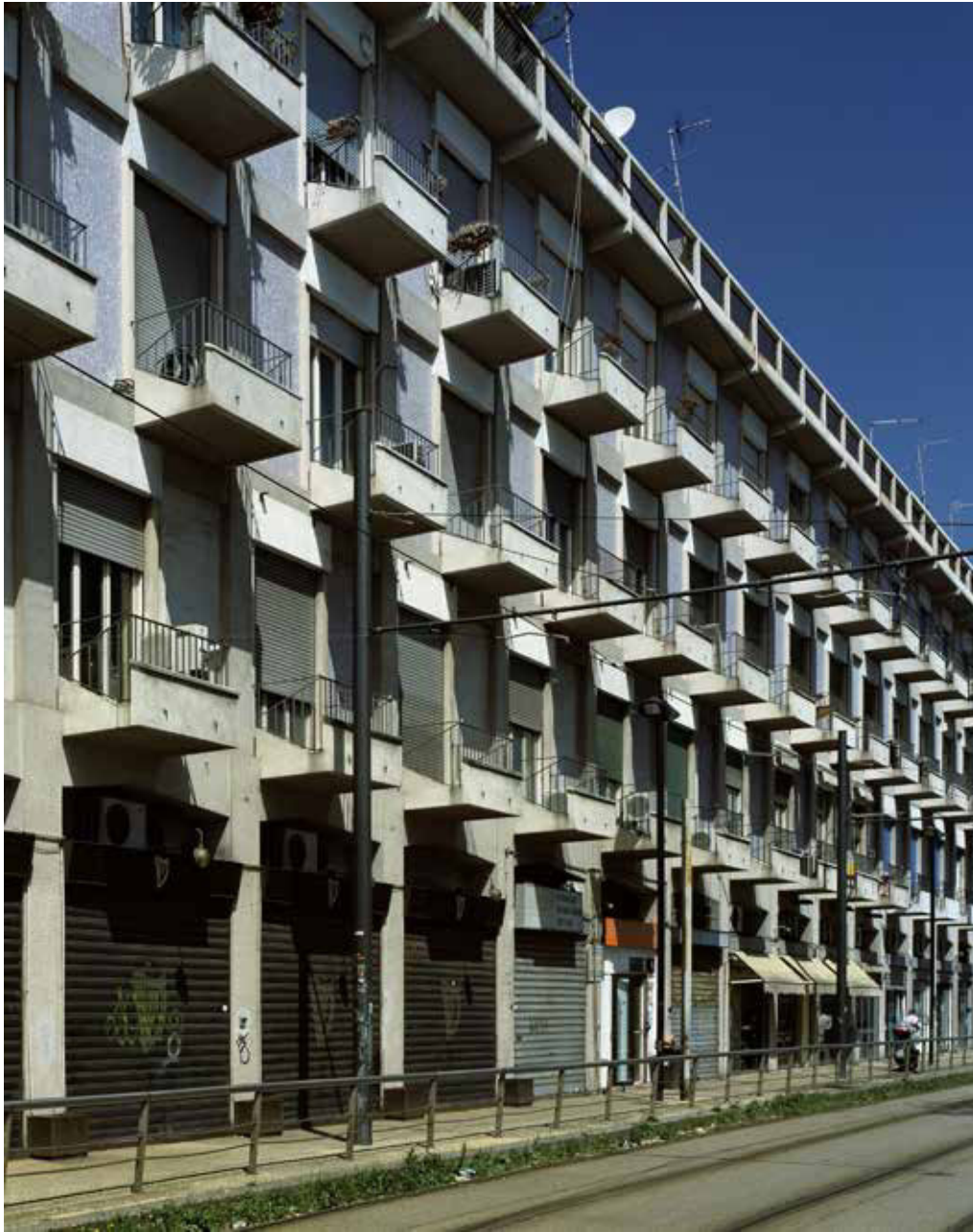
Isolato 4. Fronte a mare.
