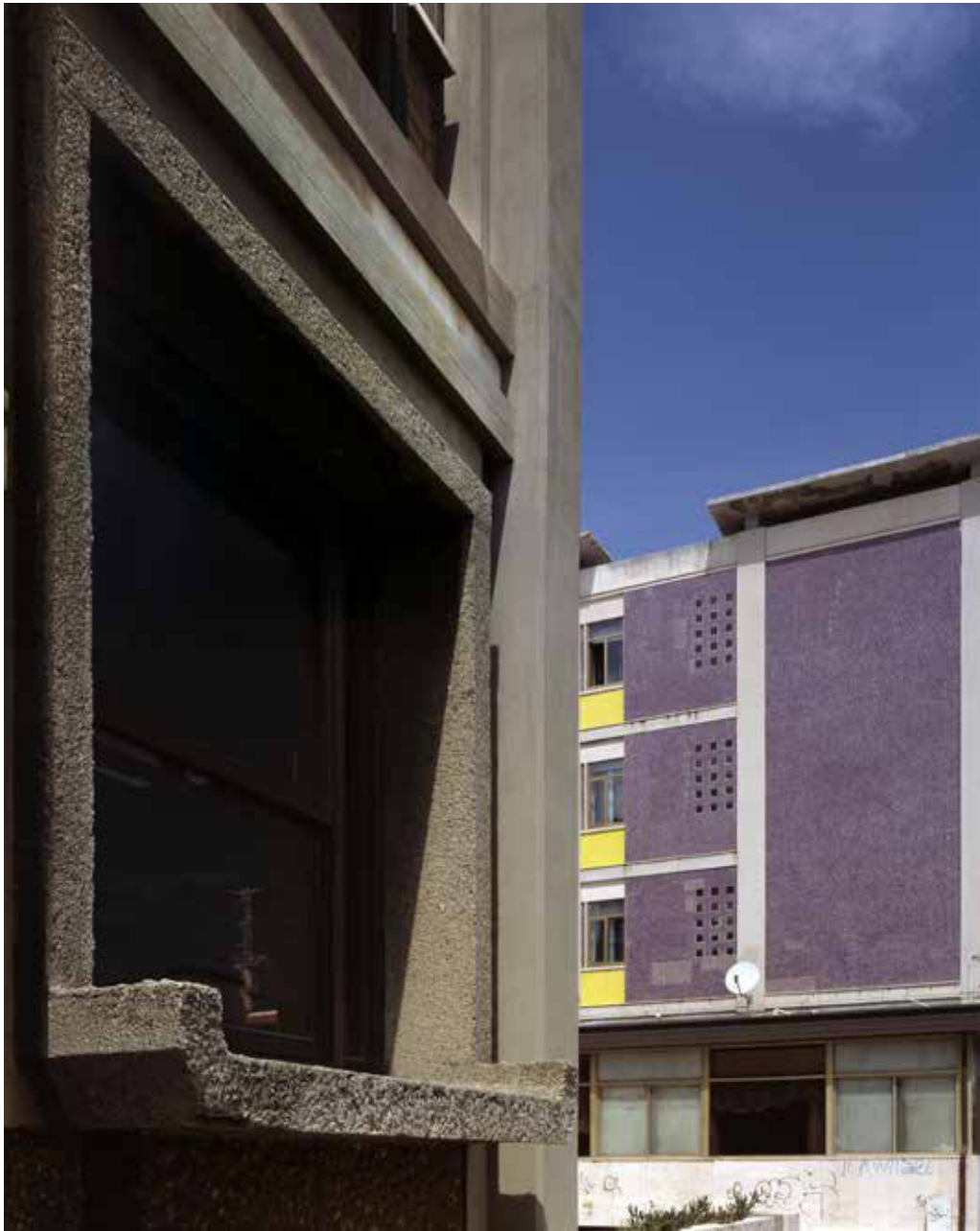
Isolato 9. Fronte mare, Palazzo dell'INPS, finestra.
