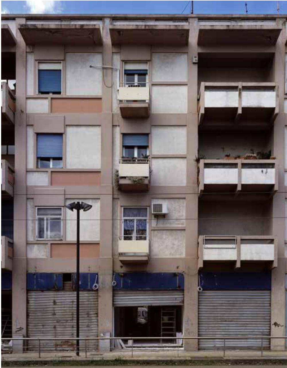
Isolato 5. Fronte a mare.
