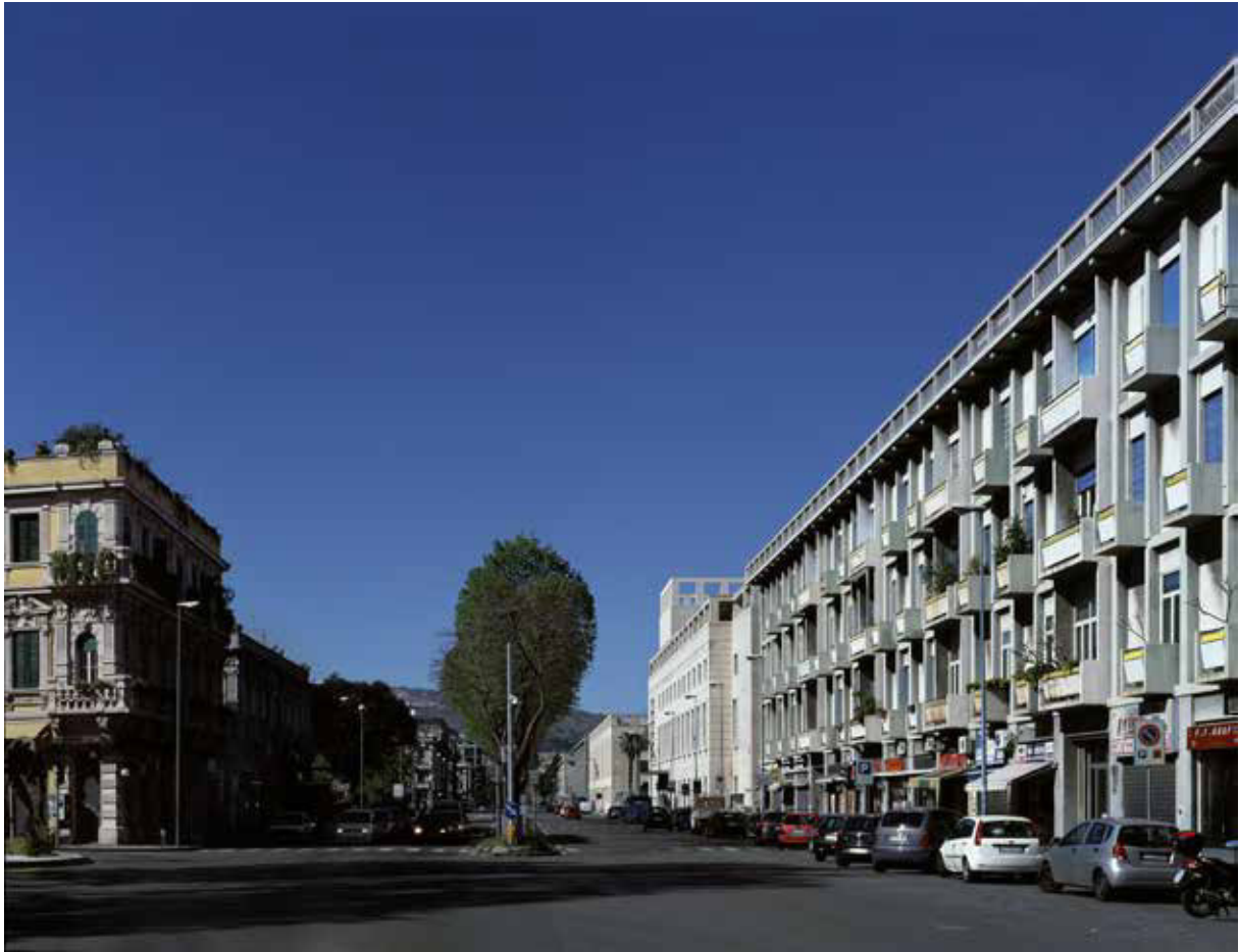
Isolato 6. Fronte Via Garibaldi.
