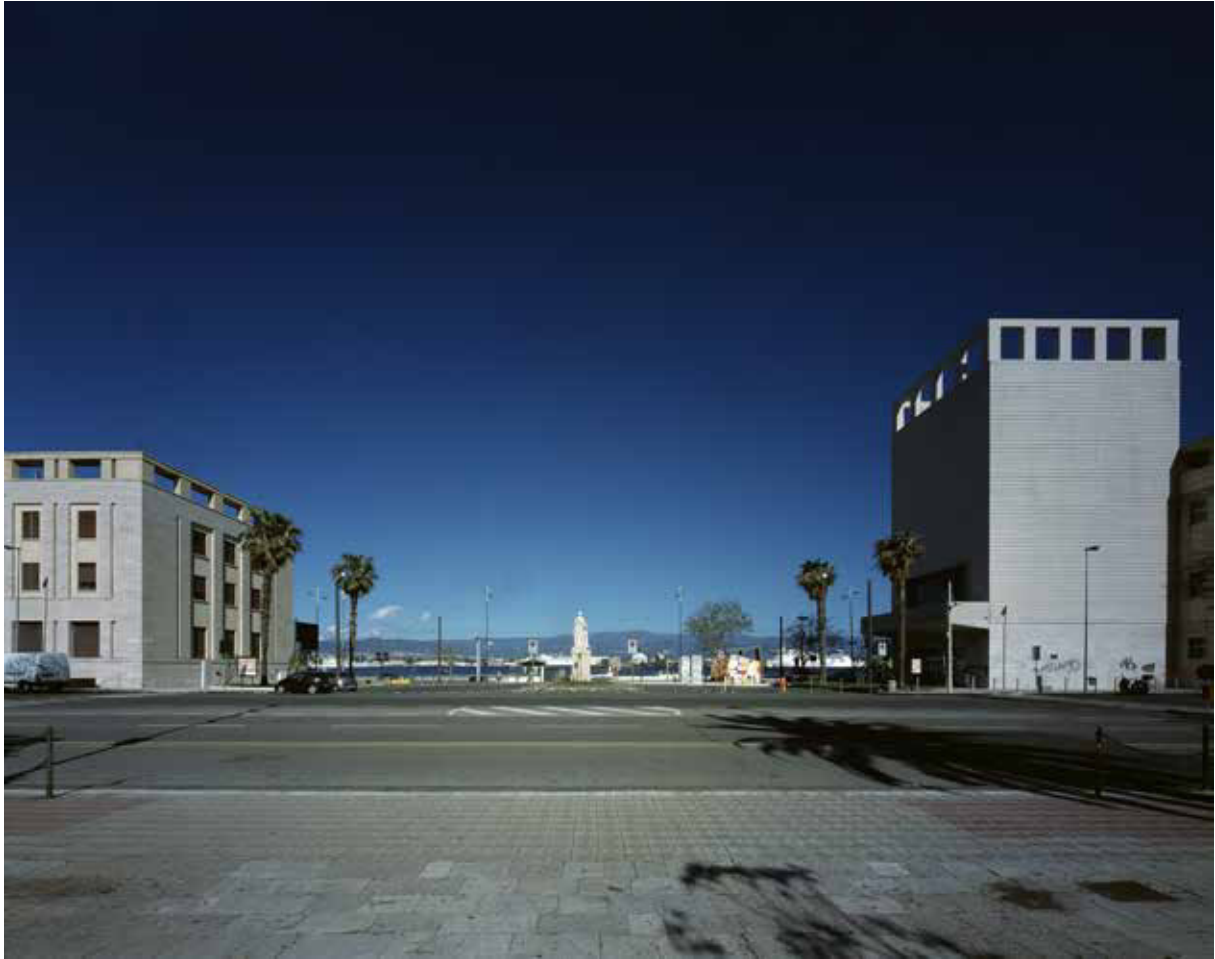
Isolato 7 e 8. Fronte Piazza del Municipio.
