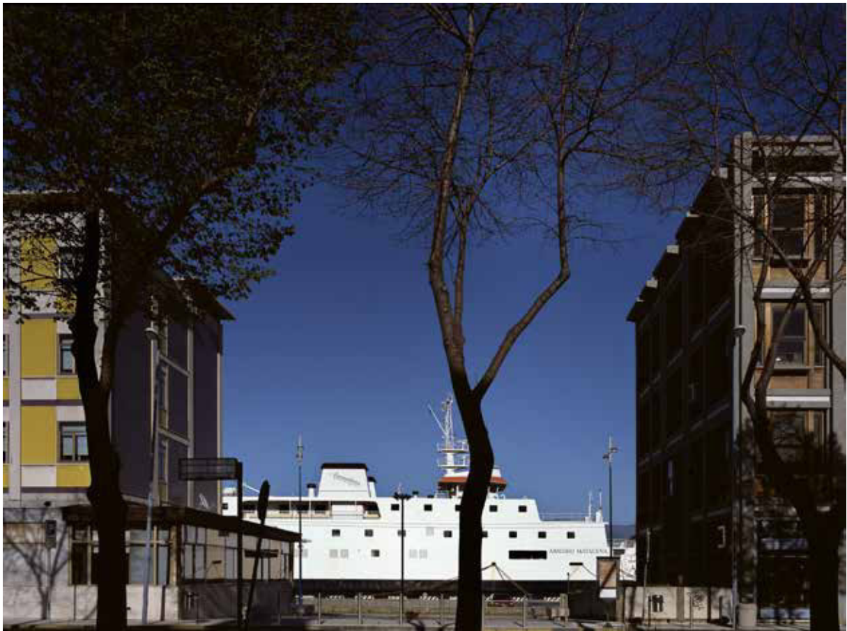
Isolato 9 e 10. Fronte via Garibaldi.
