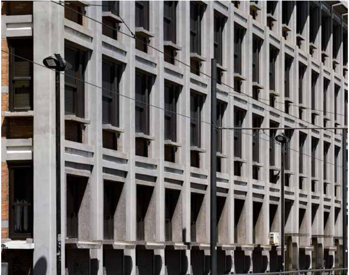
Isolato 9. Fronte mare, Palazzo dell'INPS, dettaglio.
