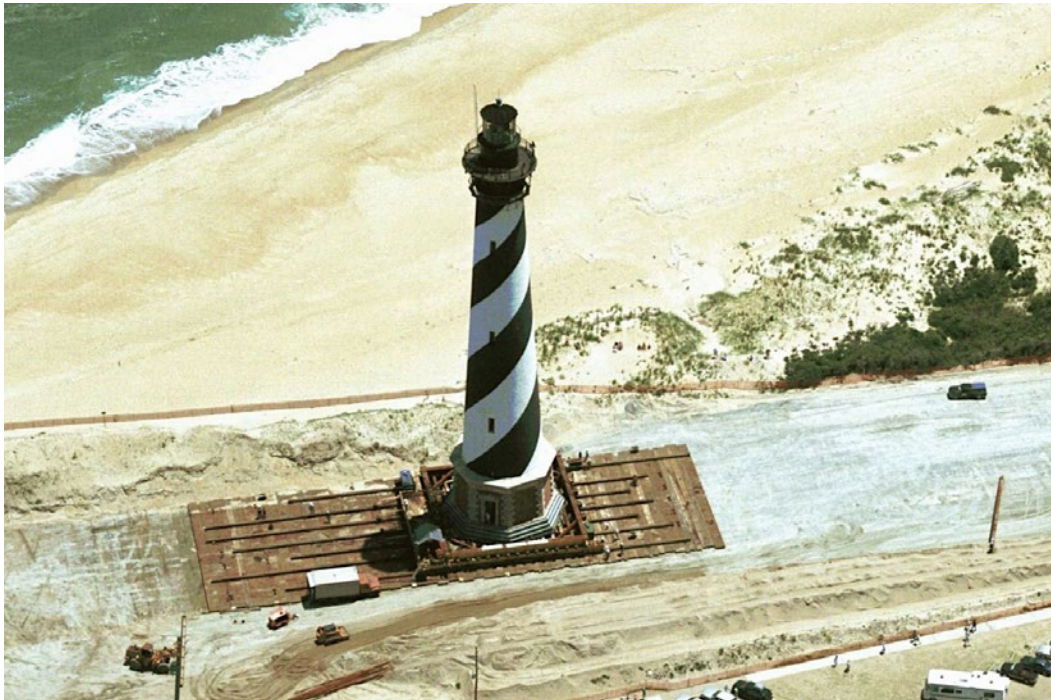
23 Lo spostamento del faro di Cape Hatteras, Stati Uniti, nel 1999.
