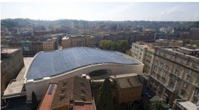
fig. 34. Sala Nervi, vista della copertura.
