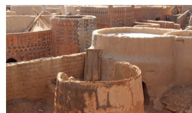
fig. 22. Coperture del villaggio di Tiebelè, in Burkina Faso. Ripiano utilizzato come essiccatoio e per dormire durante le stagioni calde.
