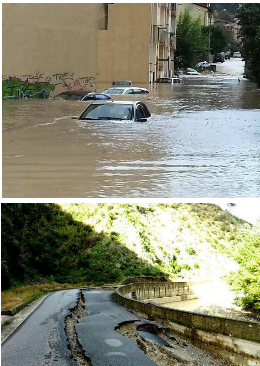
Fig. 2.5 Allagamenti e danni alle infrastrutture per l'esonazione delle fiumare nel Novembre 2013.
