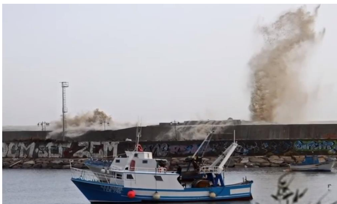
Fig. 2.7 Mareggiata del 19 Novembre 2013; il mare impatta contro il muro paraonde.
